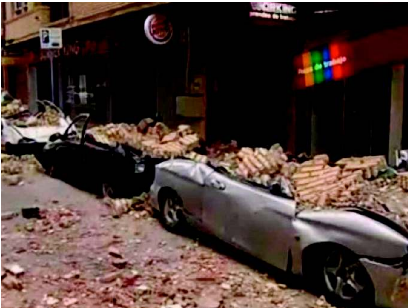
Varios coches destrozados por los escombros a causa del terremoto en una calle de la localidad murciana
